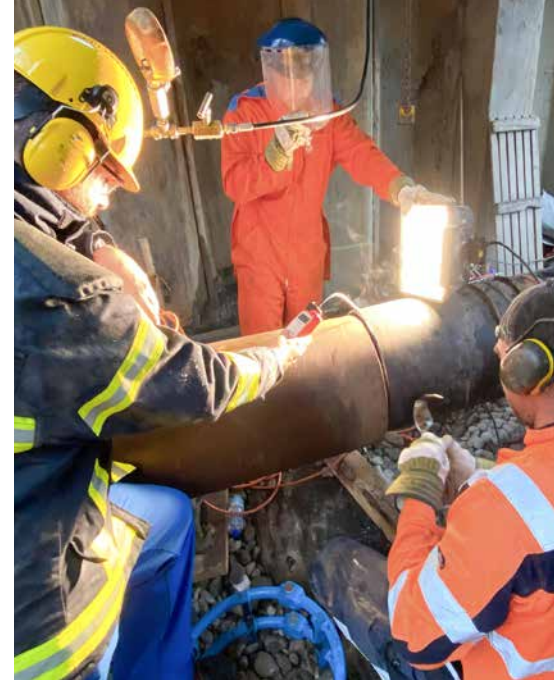
Das Schneiden erfolgte unter ständigem Messen der aktuellen Gaswerte.
