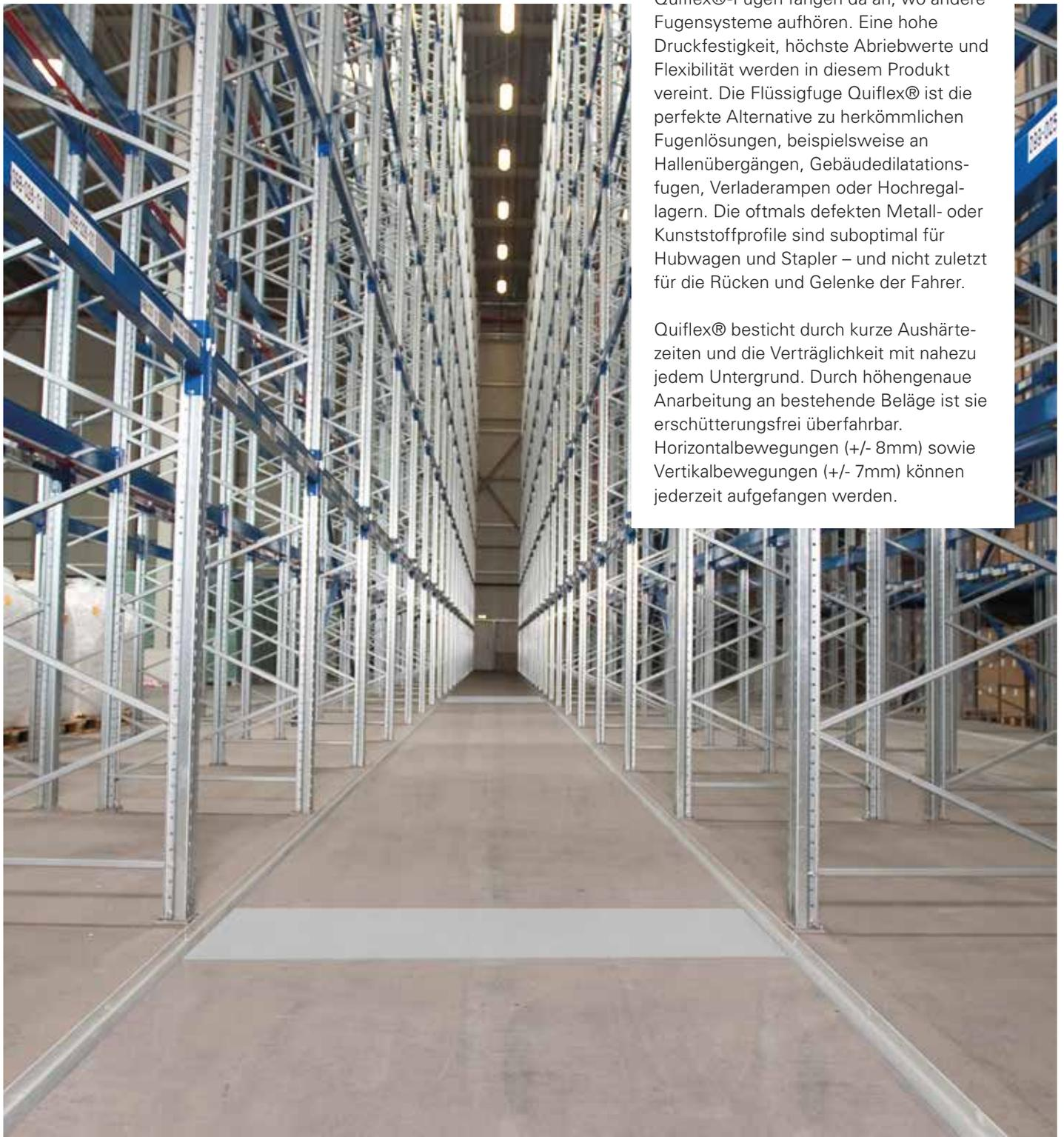
Quiflex®-Fugen fangen da an, wo andere Fugensysteme aufhören. Eine hohe Druckfestigkeit, höchste Abriebwerte und Flexibilität werden in diesem Produkt vereint. Die Flüssigfuge Quiflex® ist die perfekte Alternative zu herkömmlichen Fugenlösungen, beispielsweise an Hallenübergängen, Gebäudedilatationsfugen, Verladerampen oder Hochregallagern. Die oftmals defekten Metall- oder Kunststoffprofile sind suboptimal für Hubwagen und Stapler – und nicht zuletzt für die Rücken und Gelenke der Fahrer.
