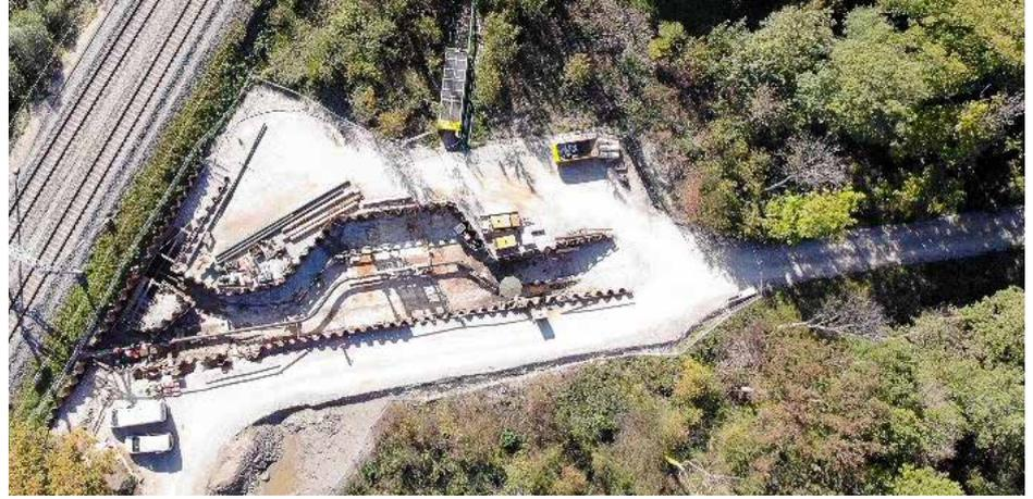
l'autorisation de l'ERI, la conduite existante a finalement pu être coupée et le nouveau poste de sectionnement a pu être intégré au tronçon. Après quatre soudures de sécurité et des tests aux ultrasons et aux rayons X réussis, les différentes zones ont été isolées et le nouveau poste de sectionnement a pu être mis en service.
