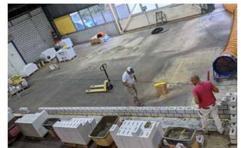
autres salles se trouvent au rez-de-chaussée. Des murs en briques silico-calcaires ont été érigés pour créer une séparation spatiale. Les nouvelles fenêtres installées entre la salle de remise en forme et l'entrepôt servent de source lumineuse et de séparation transparente entre les pièces. Pour l'évacuation nécessaire de l'eau, la canalisation a été dégagée du sol et des lavabos ont été installés. Pour la séparation entre les
